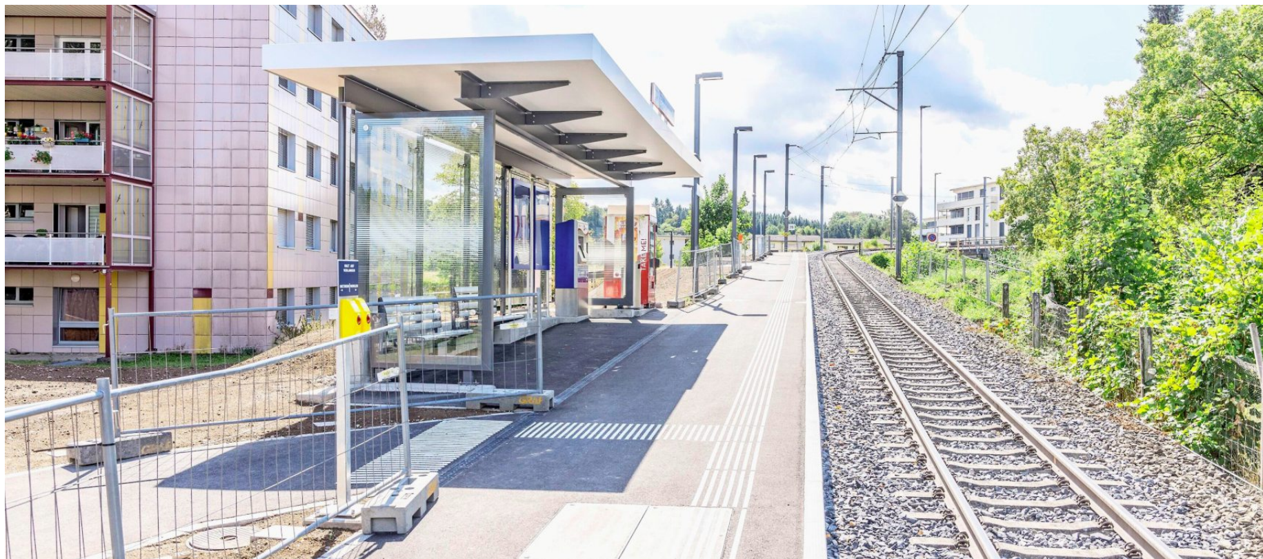
Zwar wieder offen aber noch nicht ganz fertig: Die sanierte Haltestelle Isenlauf unweit der St. Josef-Stiftung.
