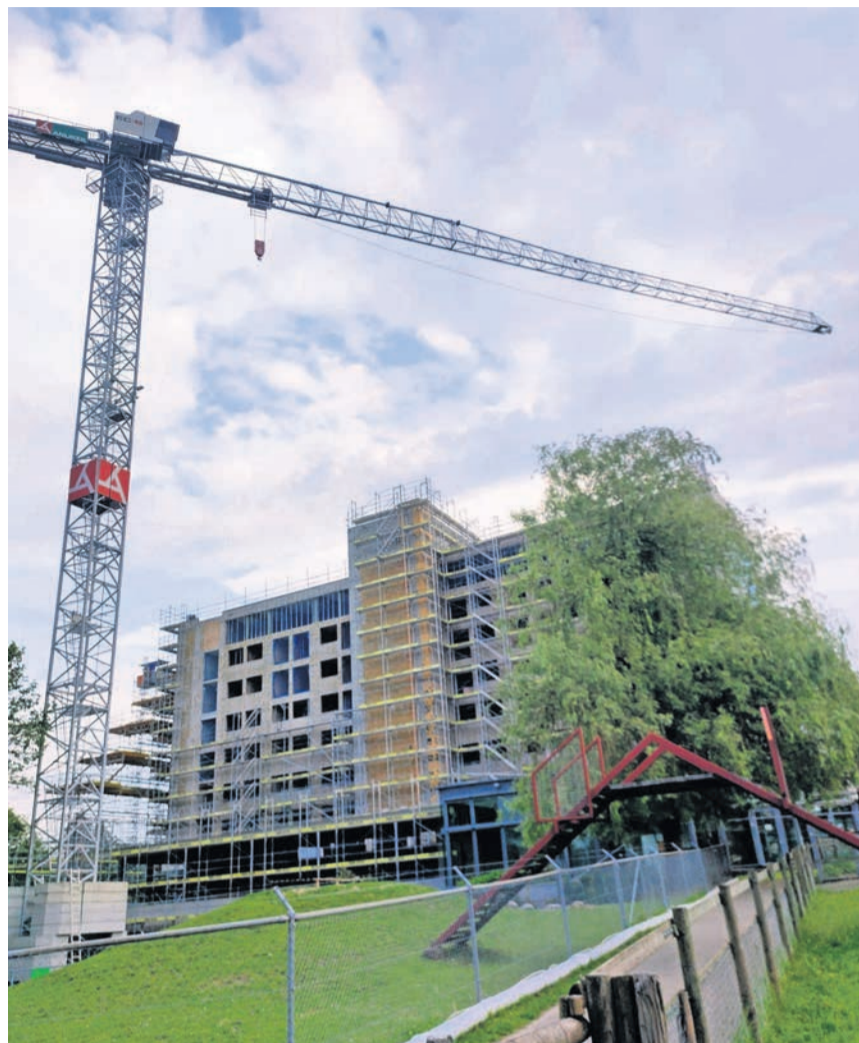
Zeiten des Umbaus: Die Baustelle prägt das Bild der St. Josef-Stiftung momentan. Bild: huy
