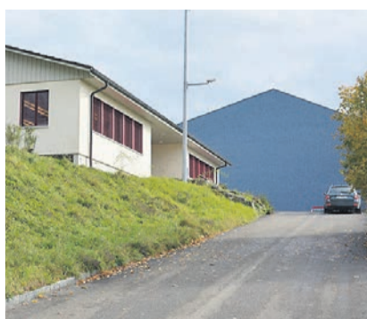
Die Sanierung und Erweiterung des Schulhauses muss man überarbeiten. Bild: Archiv
