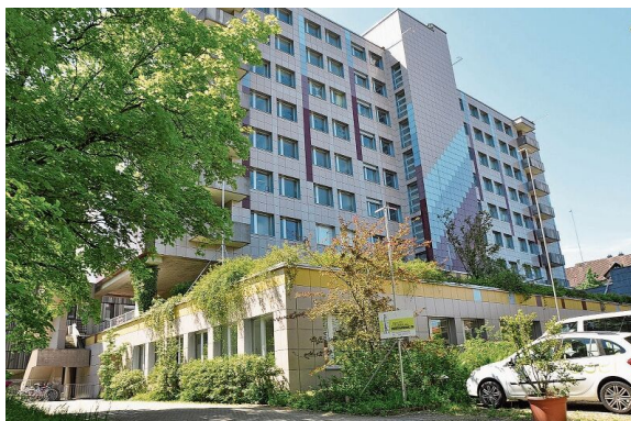
2021: Die Baugespanne zeigen auf, wo der Anbau zu stehen kommt. Bild: Nathalie Wolgensinger
