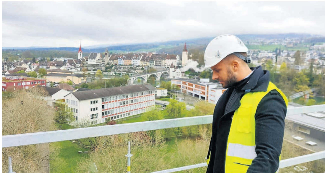
Schöne Aussichten nicht bloss von zuoberst: Die Bauarbeiten des siebenstöckigen Zentralbaus schreiten zügig voran. Bilder: Marco Huwyler
